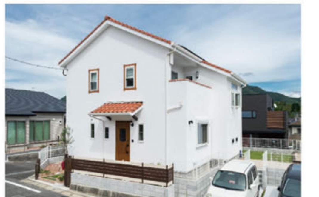
外壁は汚れにくく、雨の力できれいになる白色のスイス塗装。オレンジ色の洋瓦とのコントラストもきれいだ
